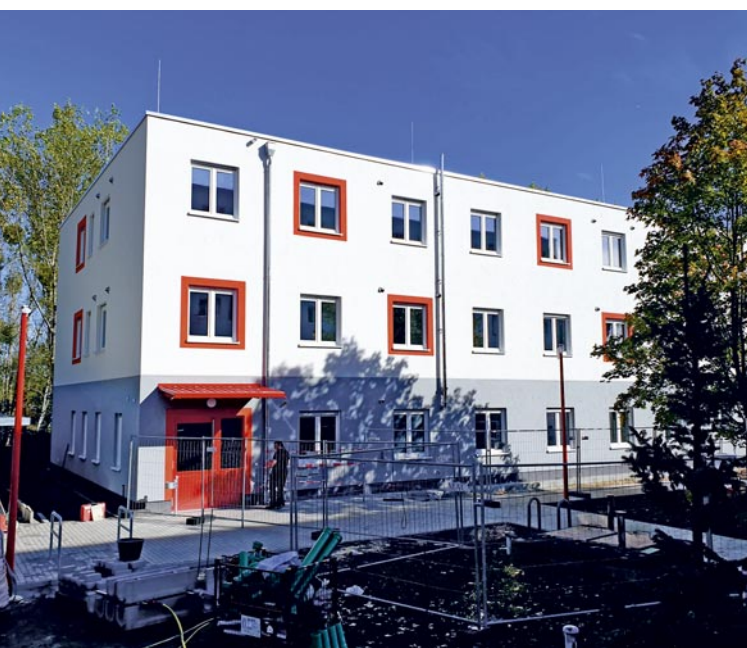
📹 Der Erweiterungsbau besteht aus 27 Modulen , die innerhalb einer Woche aufgebaut wurden. Nach einem knappen halben Jahr Bau- und Ausbauezeit ist davon weder innen noch außen etwas zu sehen. Zukünftig wohnen in diesem Gebäude bis zu 70 Menschen.
