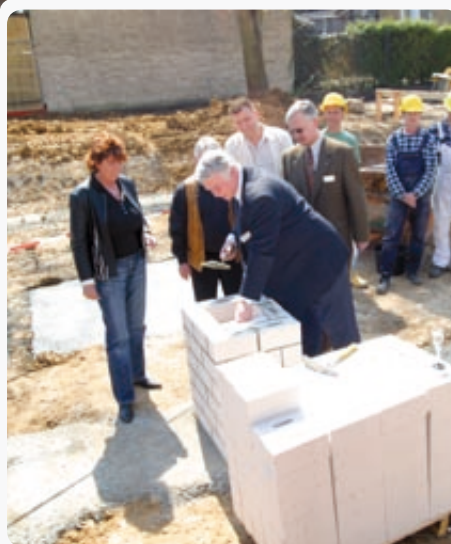
Kreispräsident Giesecke mauert die „Grundsteinbombe“ neben der bereits fertigen Bodenplatte ein
