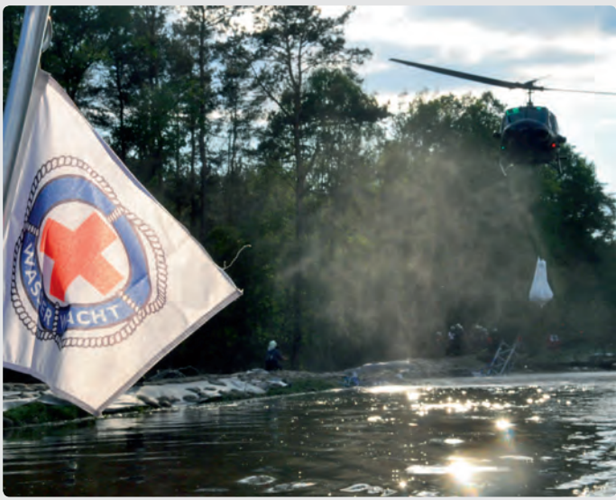
Deichsicherung durch Hubschrauber der Bundeswehr
