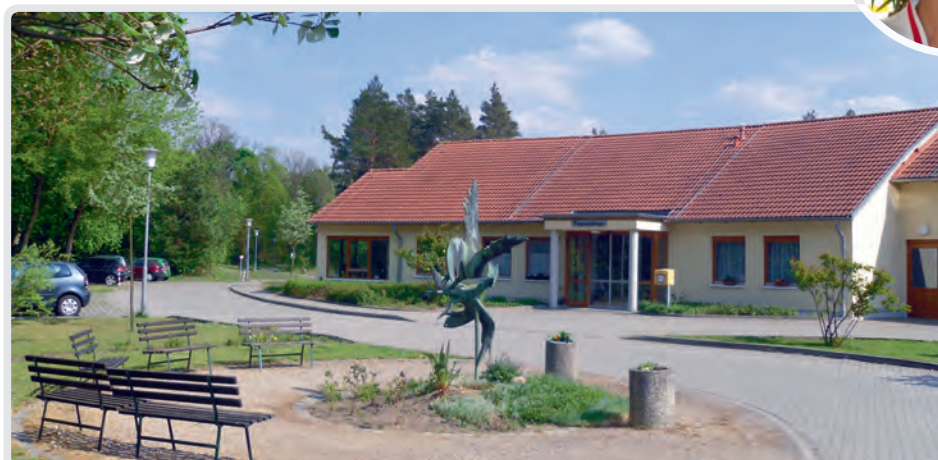
Die Tagespflege hat einen separaten Eingang mit eigenen Räumen.
