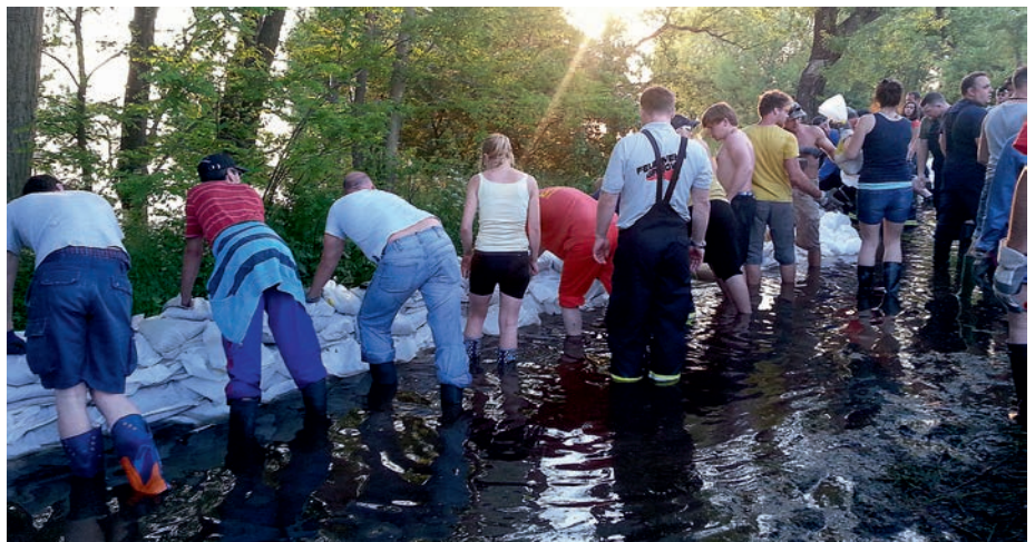
Freiwillige Helfer beim Deichbau während des Elbe-Hochwassers 2013 in Lostau
